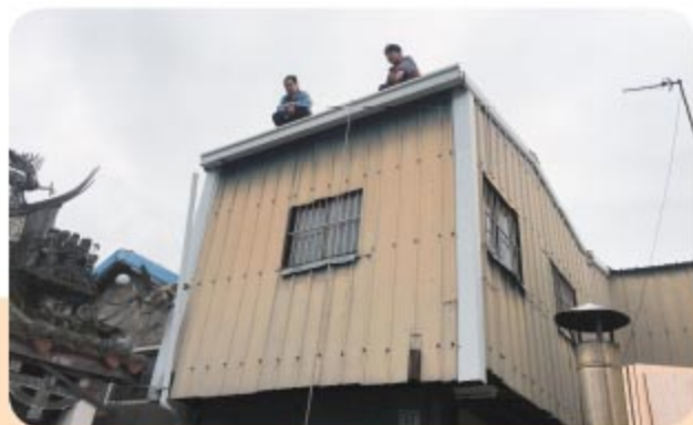
工務大哥爬上鐵皮屋頂修繕
