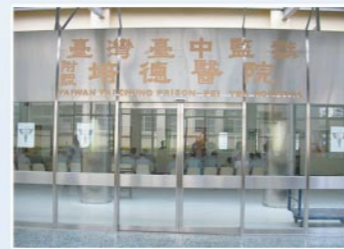
■臺灣臺中監獄附設培德醫院
