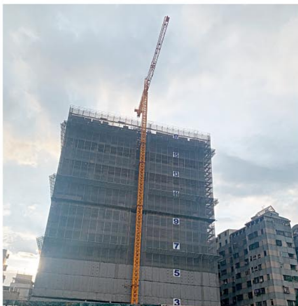
圖2：在房子還沒有蓋好以前，會使用鷹架作為支撐，讓還不夠穩定的房子能夠有支撐，並往上建蓋發展。（圖／劉光興提供）
